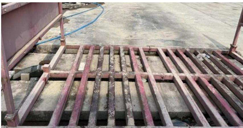
图 3-1 已实施施工现场洗车平台
